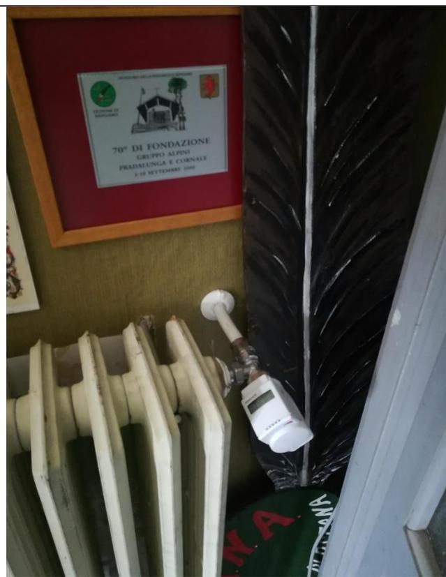
Termosifone a piastre modello BIASI LBT (da rimuovere valvola esistente e installazione di nuova termostatica elettronica compatibile)
