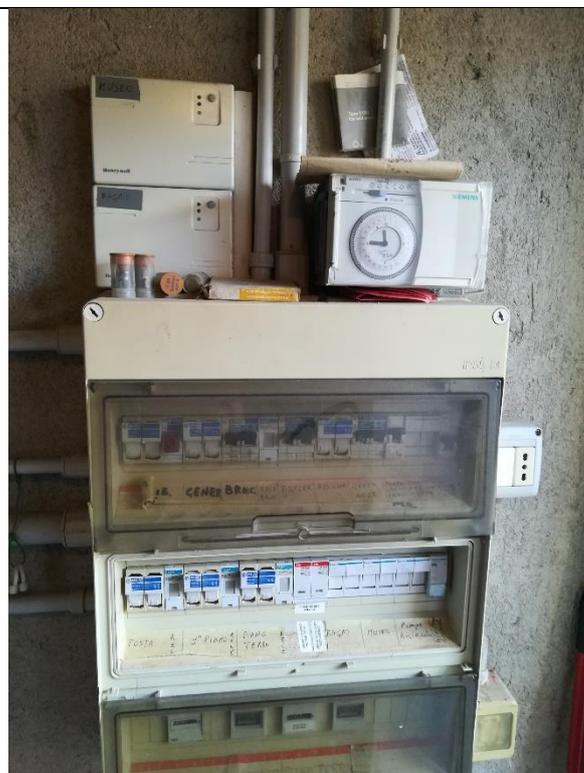
Quadro elettrico centrale termica con climatica + sistemi di controllo valvole (da rimuovere e rifare)
