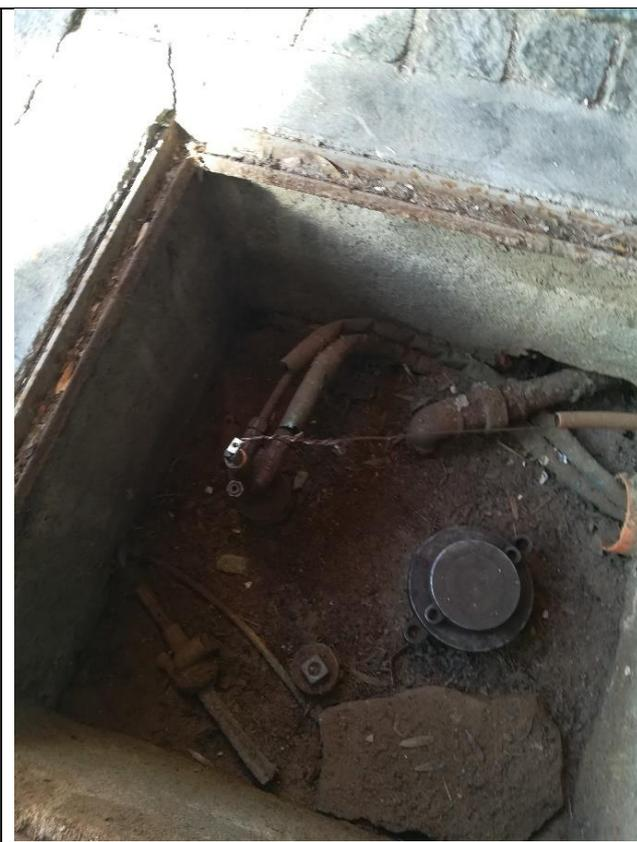
Pozzetto caricamento serbatoio interrato gasolio (da bonificare e rimuovere)
