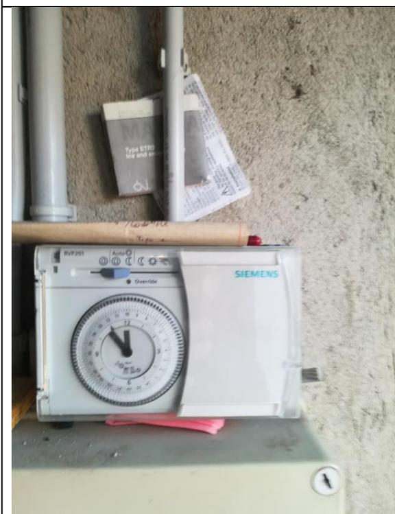
Centralina climatica Siemens posta in C.T. (da sostituire)
