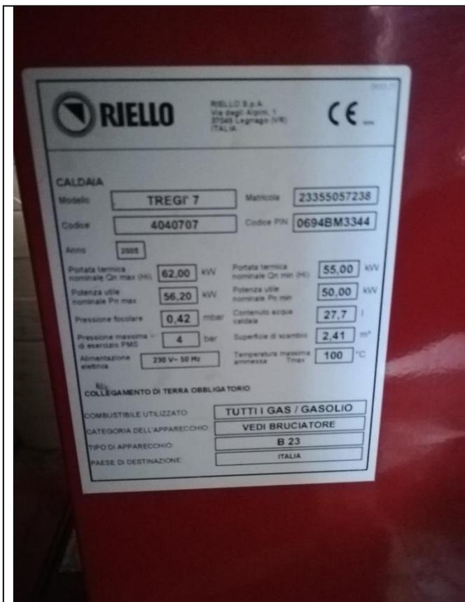
Targa caldaia esistente (da rimuovere)
