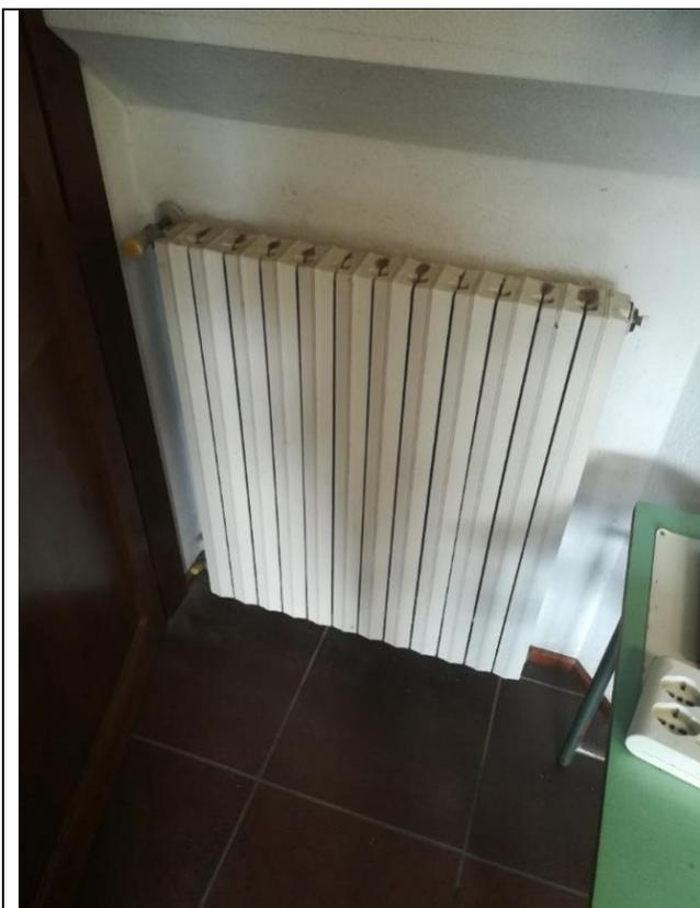
Termosifone a piastre modello BIASI PRR (da installare valvola termostatica elettronica)
