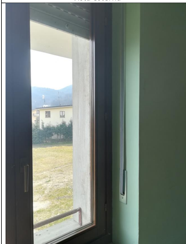
Serramenti esistenti con vetro doppio
