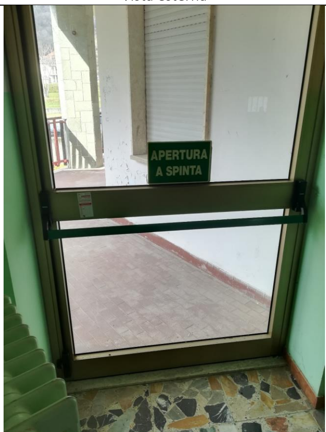
Porte di sicurezza con vetro singolo antisfondamento
